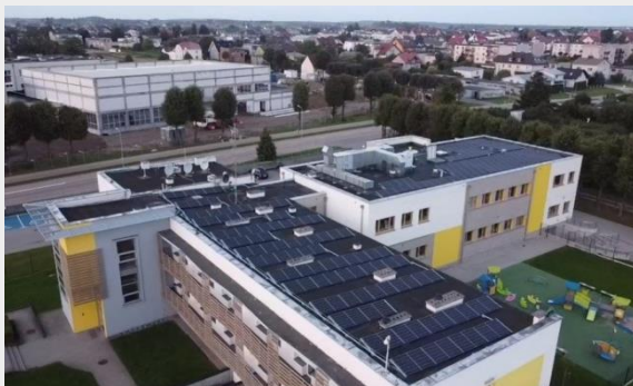
Instalacje fotowoltaiczne na żłobku i budynku socjalno-sportowym w Brusach
